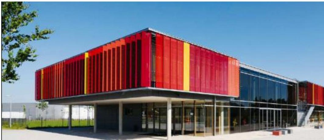
Abbildung 22: Beweglicher außenliegender Sonnenschutz [17]
